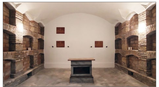
Die Krypta unter der Stadtpfarrkirche erstrahlt nach der Renovierung seit März in neuem Glanz.
